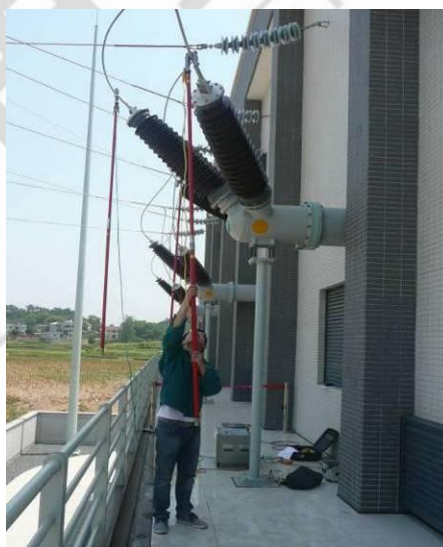
图 6-2：测试线通过绝缘棒引到被测线路上
